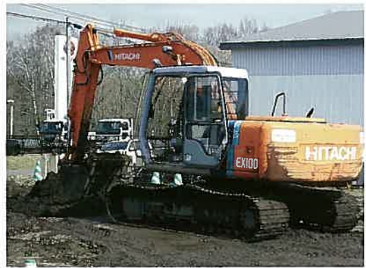
車両系建設機械（整地）
